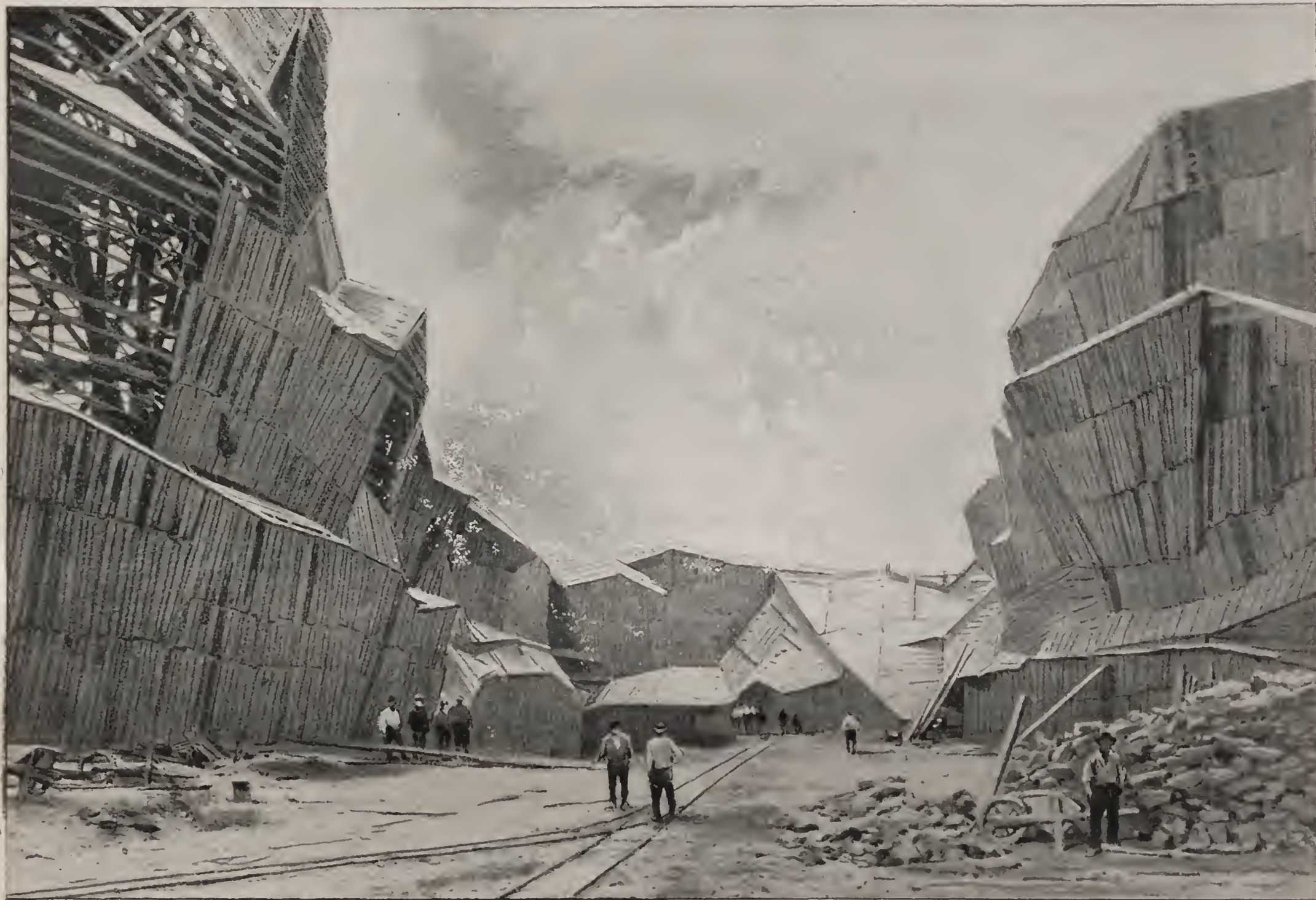
LE VILLAGE SUISSE A L'EXPOSITION DE 1900. — Habillage en planches de la carcasse des montagnes.
